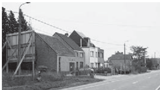
Foto 1-1: Begin Hoolsterberg, links van de weg zien we de huizen met de nummers A, 1 (tweewoonst) en B.
